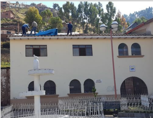
Reparatur Dach des Ambulatoriums
