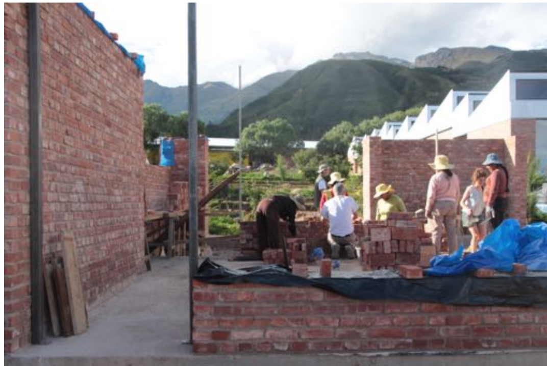
Baustelle Internat März 2017
