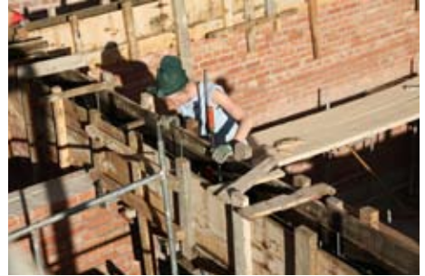
KONTROLLE DER SCHALUNG
