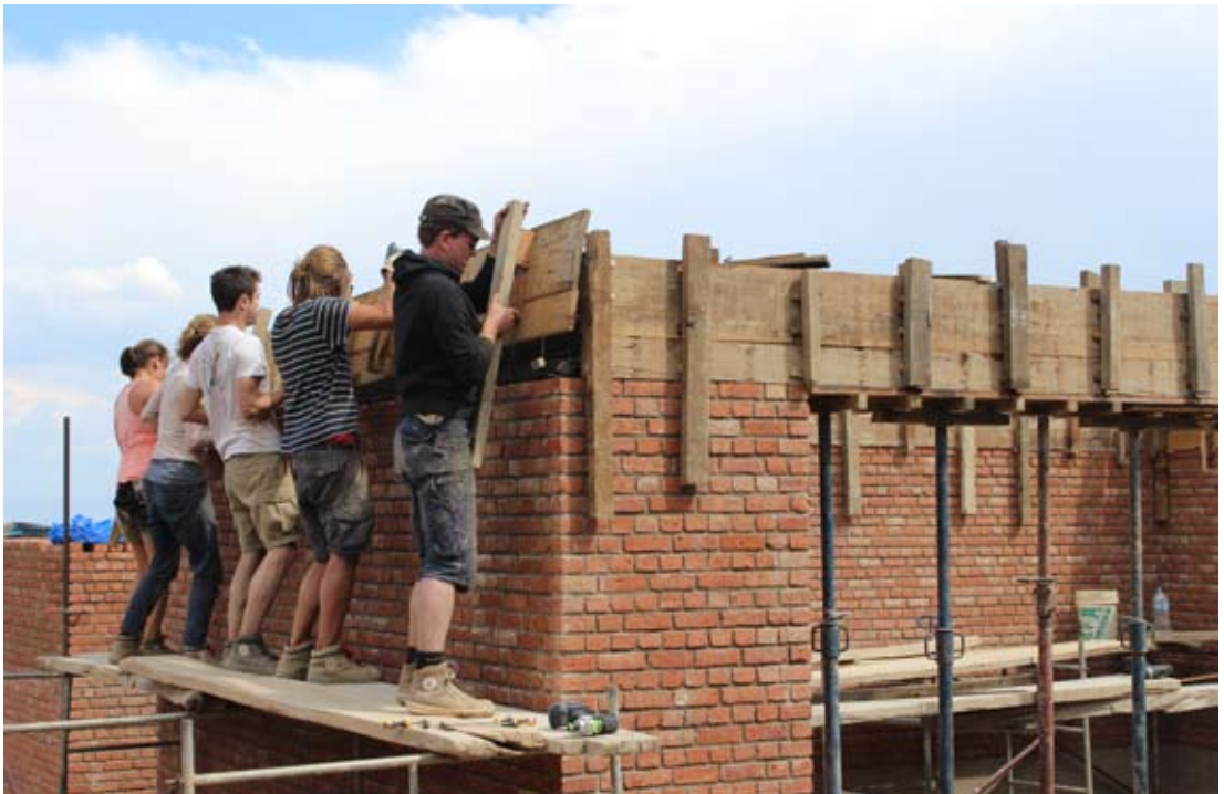
MONTAGE DER ERSTEN SCHALUNG
