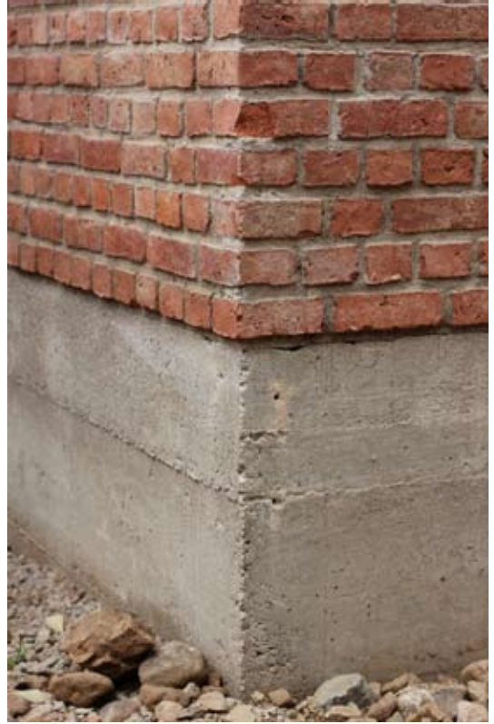
ANSCHLUSS MAUERWERK AN SOCKEL
