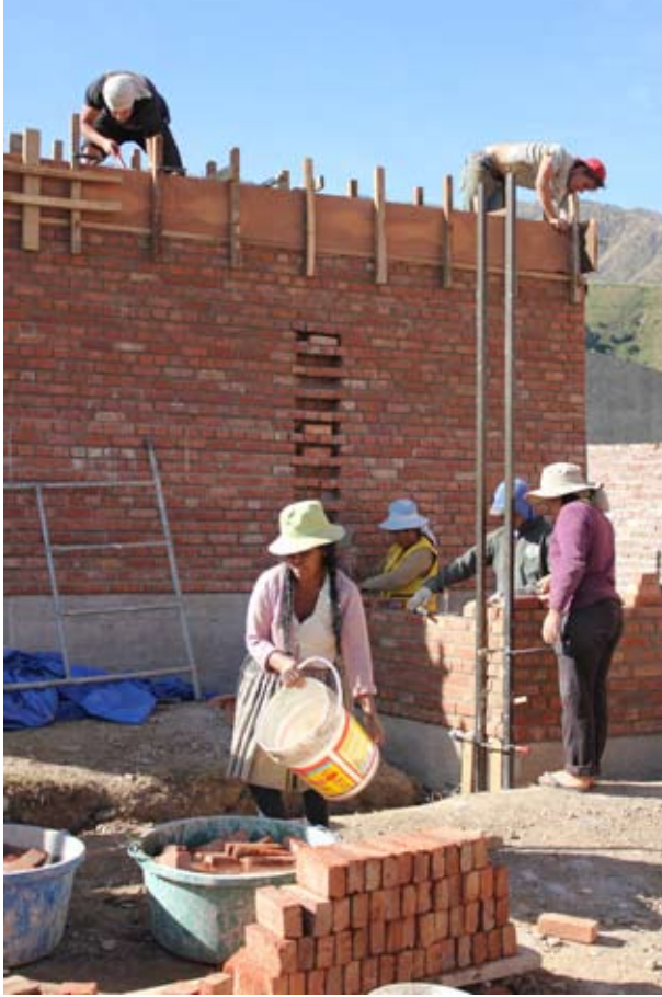
PARALLELES ARBEITEN AN MAUERWERK UND RINGBALKEN
