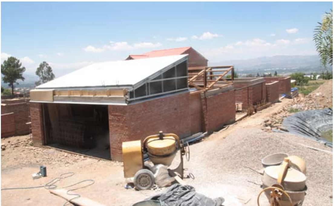
STAND DER ARBEITEN NOVEMBER 2014
