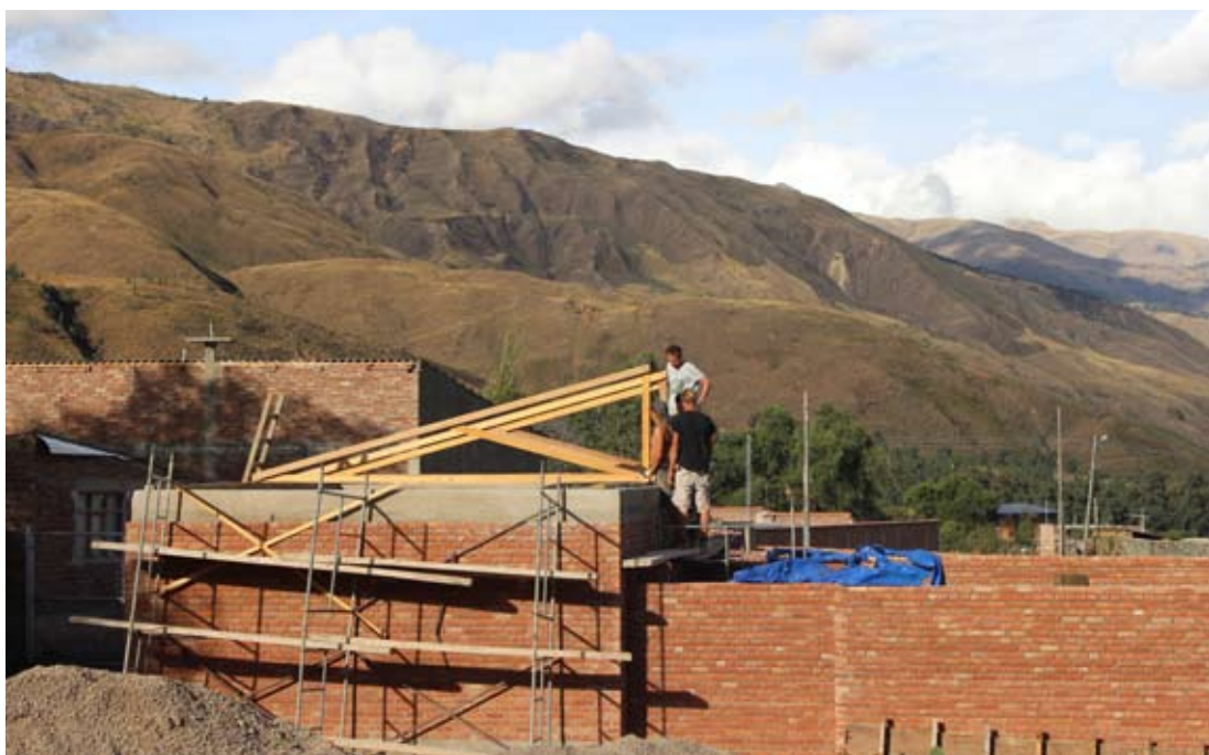
MONTAGE DER ERSTEN TRÄGER
