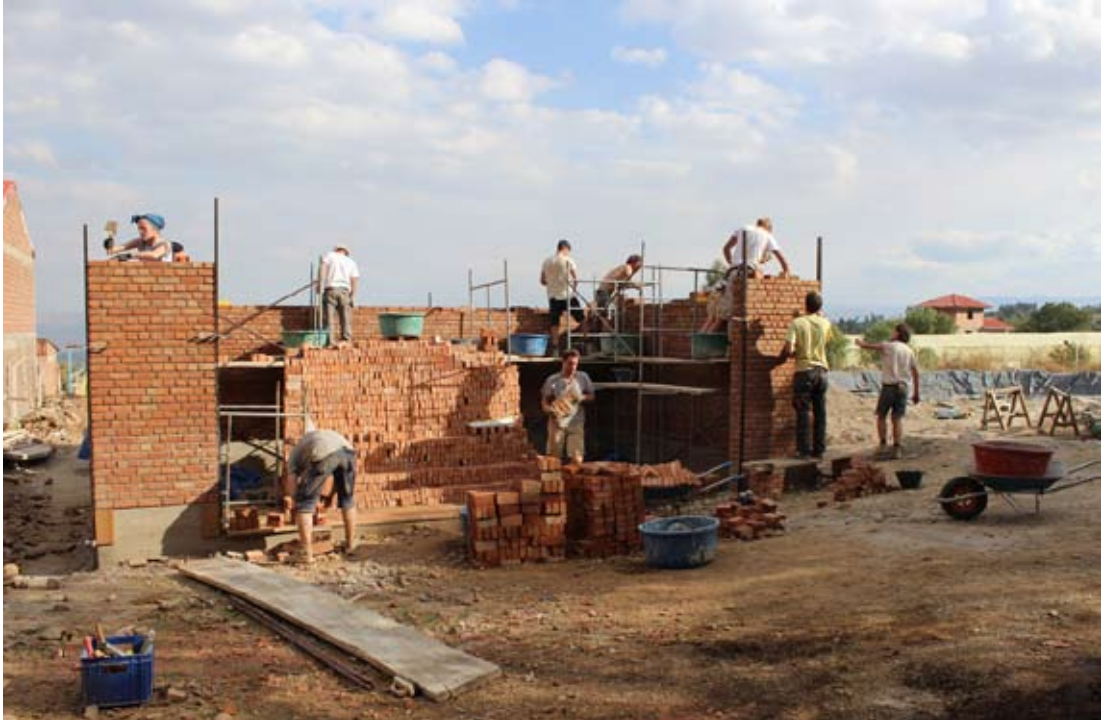
UMSETZUNG DER IN MASSIVER BAUWEISE GEPLANTEN GEBÄUDESTRUKTUR DURCH DIE STUDIERENDEN DER TU BERLIN
