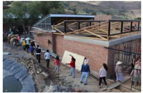
GEMEINSAMES GIESSEN DES RINGBALKENS
