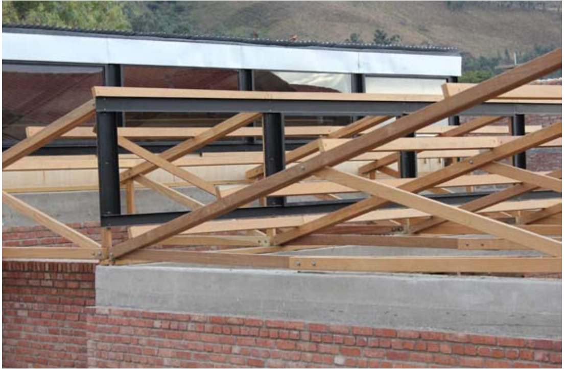
EINBAU DER OBERLICHTER
