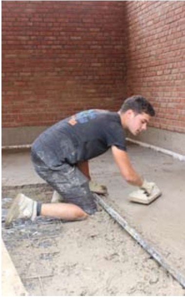
GLÄTTEN DES BETONBODENS
