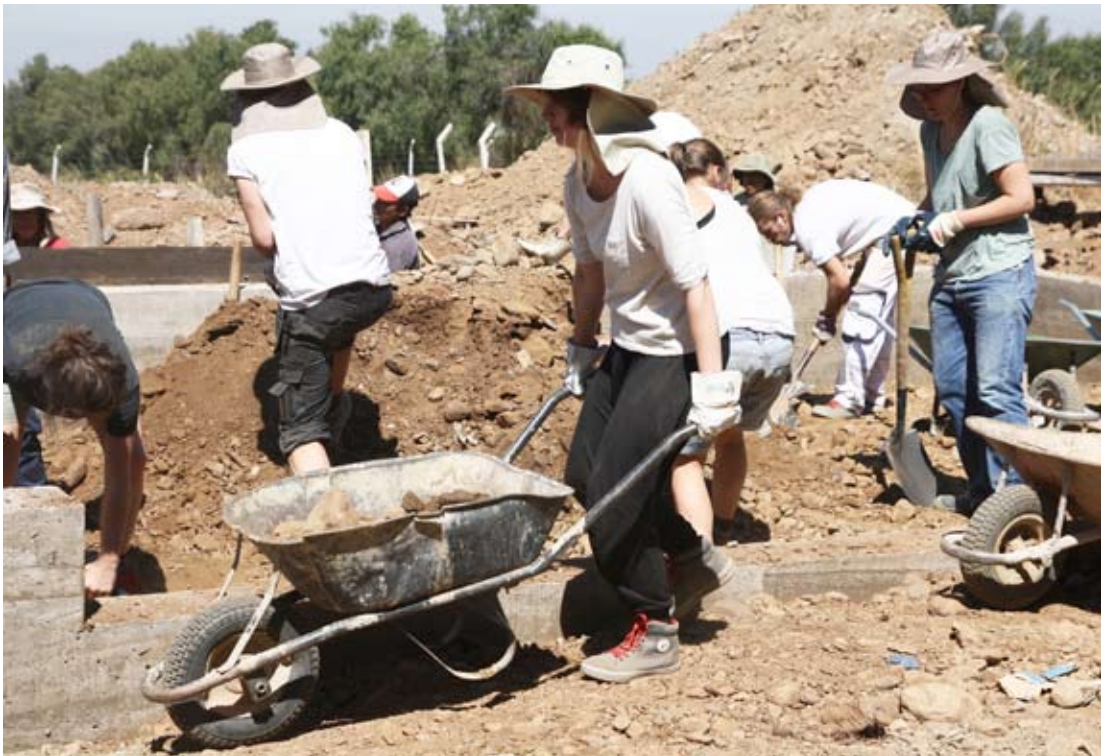
BAUSTELLENVORBEREITUNG IN DER ERSTEN WOCHEN DURCH ALLE STUDIERENDEN
