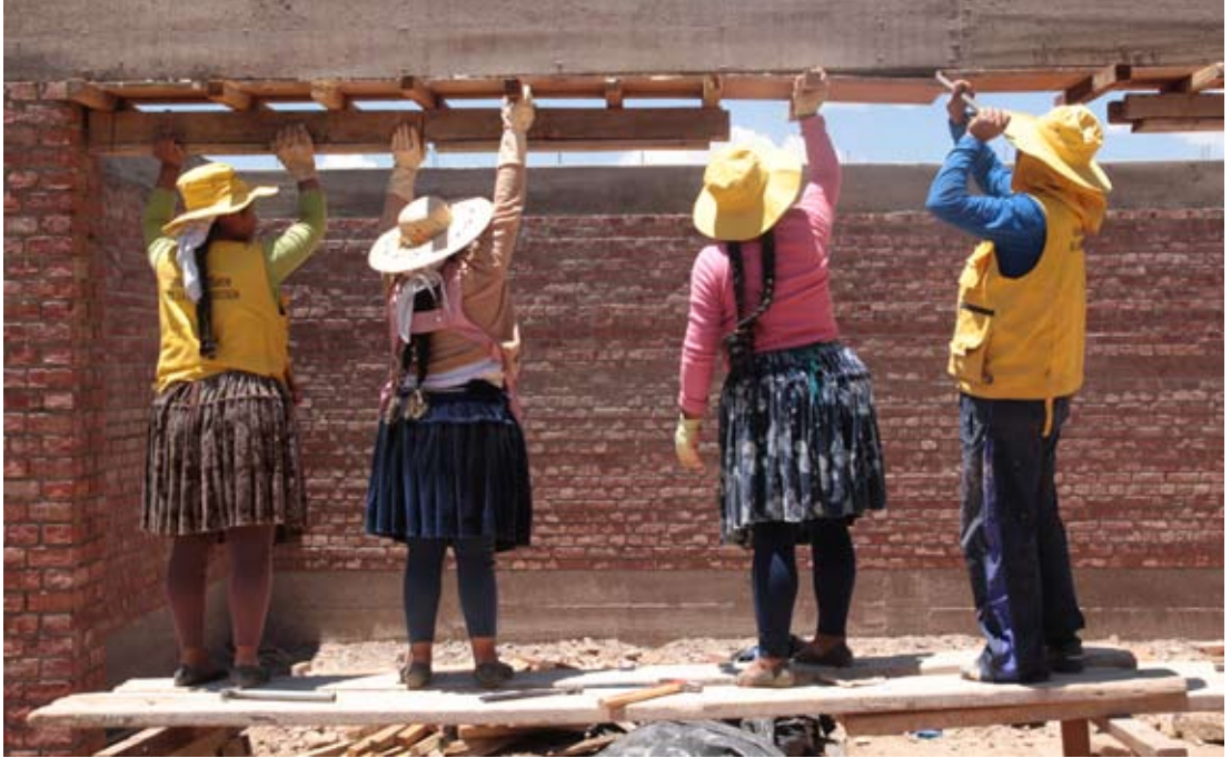
ENTSCHALEN EINES RINGBALKENS DURCH DAS TEAM VON PROCASHA
