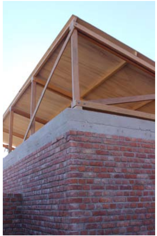
UNTERANSICHT DES DACHES
