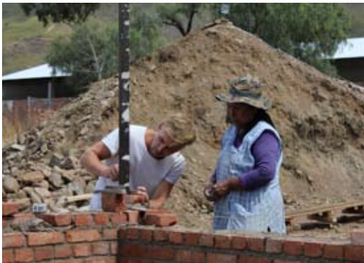
ZUSAMMENARBEIT AUF DER BAUSTELLE
